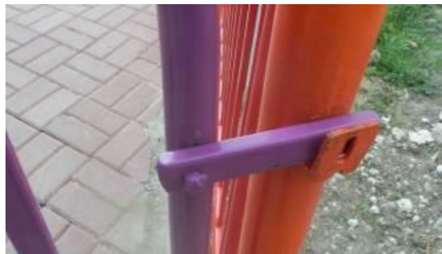
Фиг. 3. Некой от детайлите от важни функционални елементи са проектирани и изпълнени елементарно, и непрофесионално (фотография на автора).
