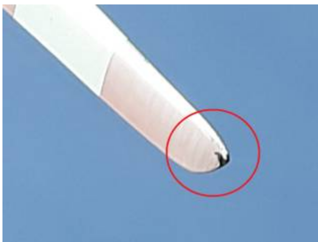
Фиг. 5 Нарушение на обшивката на крило при върха
