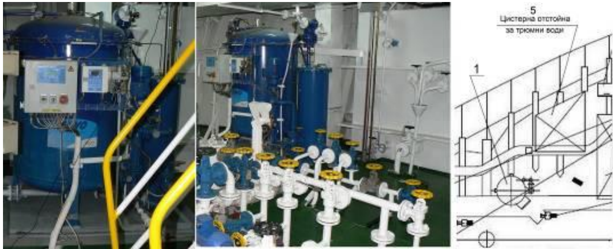
Фиг.2. Общ вид на трюмния сепаратор (поз.1) на плитовете в машинното отделение на кораба
