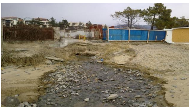
Фиг. 1 Поглед към обекта и изградената временна охранителна канавка от югозападната страна на обекта, чрез която дъждовните води се отвеждат в Черно море
