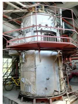
Фиг. 1. Котел в ОЦ на ТУВ – общ вид след започнати операции по отрязването му.
