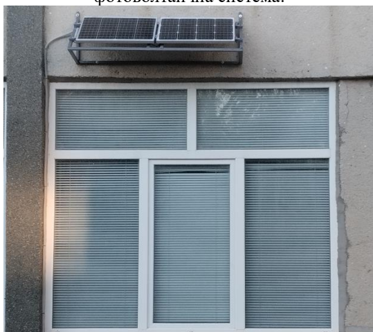
Фиг.2. Инсталирани фотоволтаични модули.
